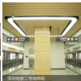
深圳地铁二号线照明
